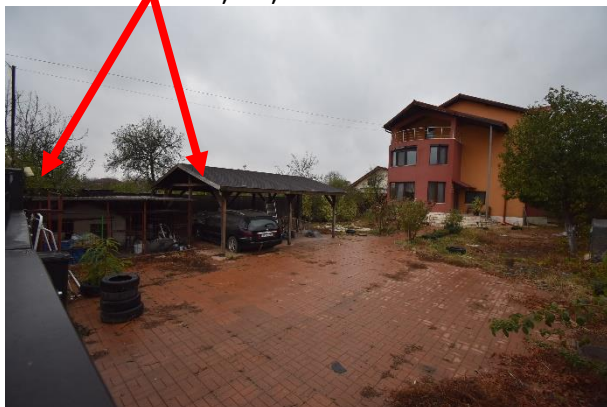
Vedere construcții ușoare neintabulate:
